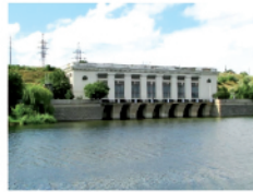
Снігурівська насосна станція - головне джерело постачання Інгулецького каналу
